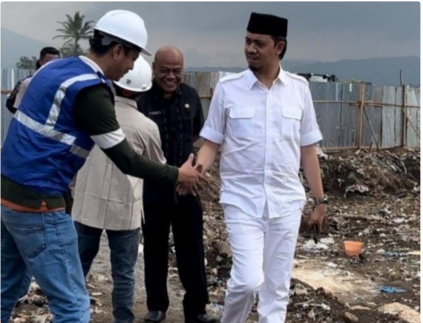
Wako Erman Tinjau Proses Pembangunan Tempat Pengelolaan Sampah Terpadu
