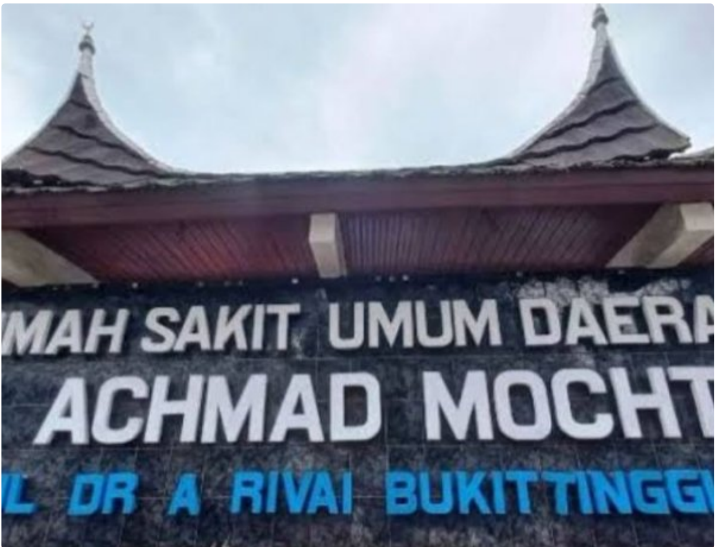
Rumah sakit Ahmad Mohtar Bukittinggi
